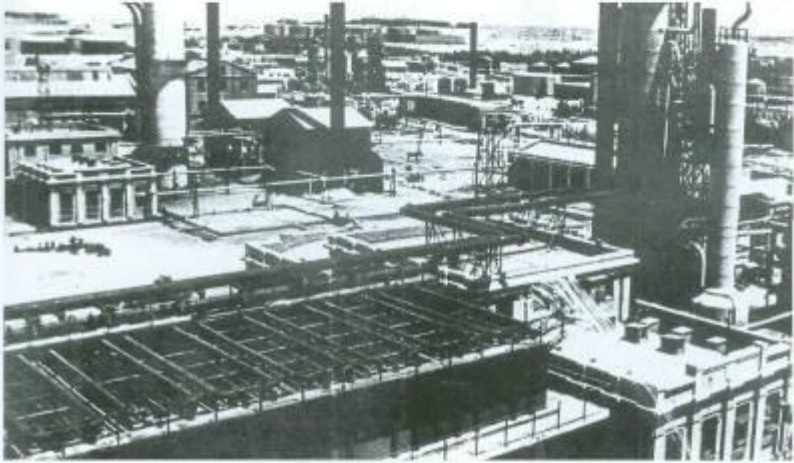
Şökil 25. Bakı şəhərində neftayırma zavodunun ümumi görünüşü (1937)
